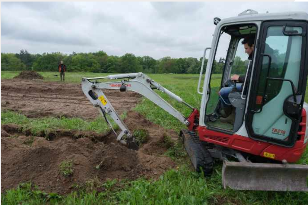
Figuur 3. Graven van sleuf aan de rand van proefvlak om folie in te bevestigen.
